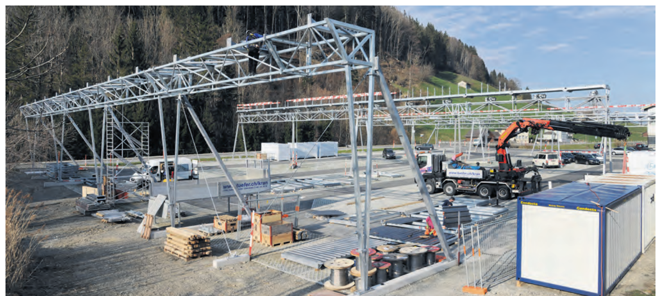
Seit rund drei Wochen läuft die Montage der Trägerkonstruktion des 80m langen und 45m breiten Solarkraftwerks. (Bild: Hans Ulrich Gantenbein)
